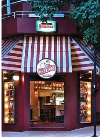
Figura 34. A fachada foi restaurada, valorizando-se a tipologia do sobrado de esquina. Imagem e legenda.
