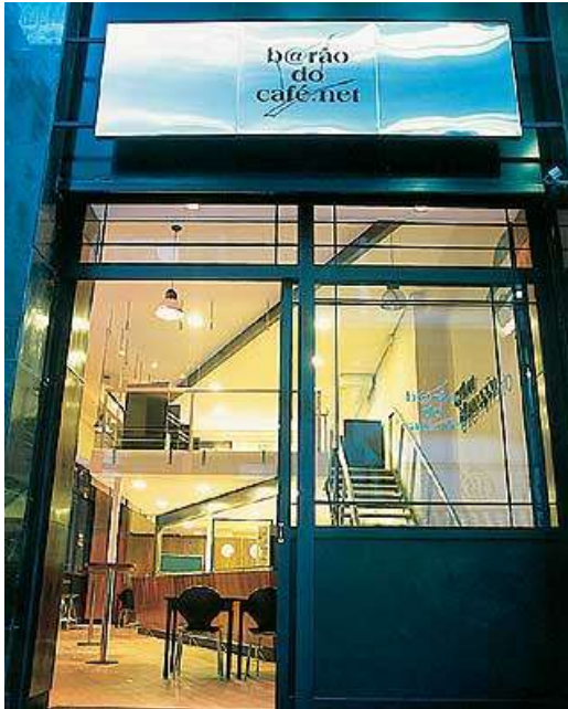
O pórtico metálico substituiu o antigo sistema estrutural do edifício
