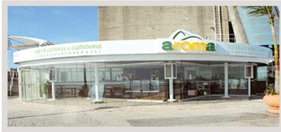
Figura 5: Vista externa após a reforma Fonte: Panrotas apud Vargas, 2008 (acervo do relatório de pesquisa).
