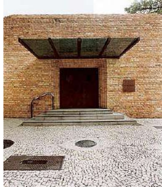
A cobertura de vidro protege a entrada
