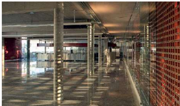
Vista interna da face oeste. O espaço entre os pilares e a vedação corresponde ao balanço da marquise
