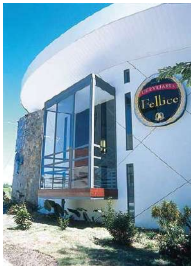
Detalhe da circulação vertical que se projeta da fachada
