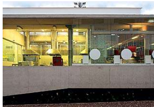
Grandes panos de vidro dão transparência à cozinha e ao salão
