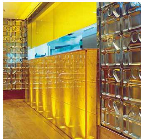
Laterais do passa-prato são ocupadas por painéis de bandejas de alumínio
